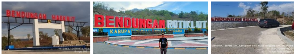
Gambar 30. Bendungan pendukung pengairan FE Belu
